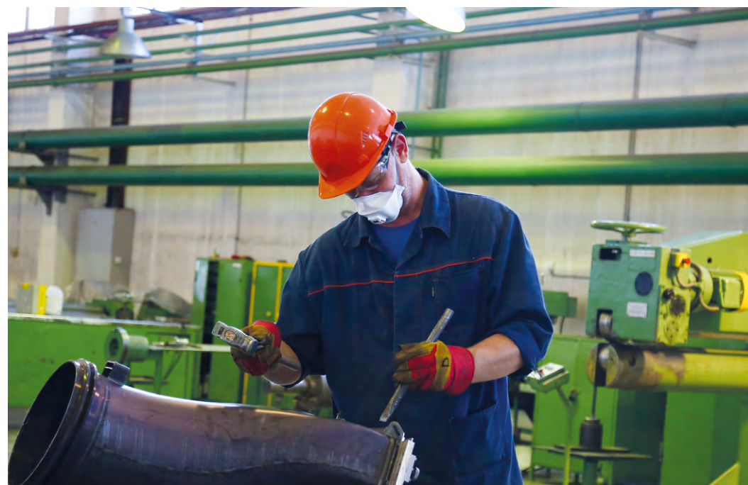
Подгонка и установка уплотнений патрубка переходного ГТК-25ИР
