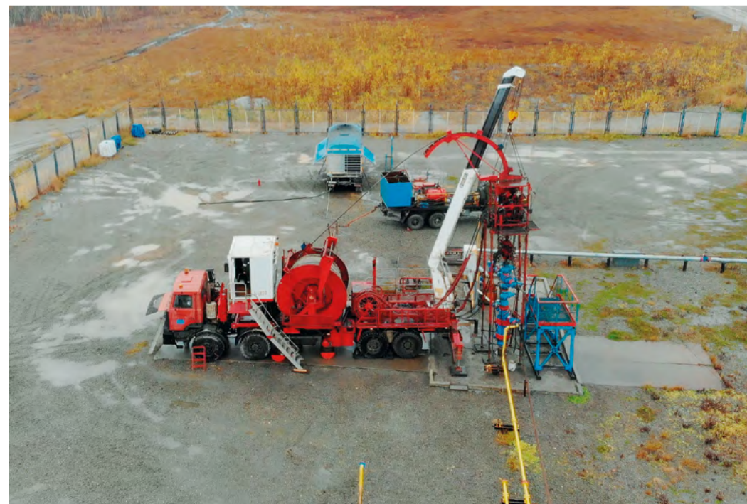
Бригада Ноябрьского управления интенсификации и ремонта скважин выполняет работы на Киукомском газоконденсатном месторождении на Камчатке
