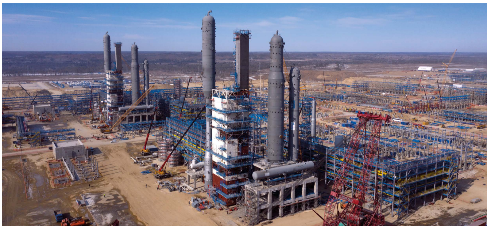
Строительная площадка Амурского газоперерабатывающего завода
