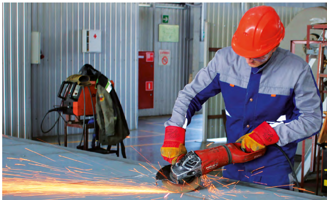
Защитка сварочных швов блок-бокса БКЭС
