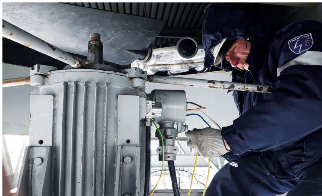
Ремонт электрооборудования аппарата воздушного охлаждения газа
