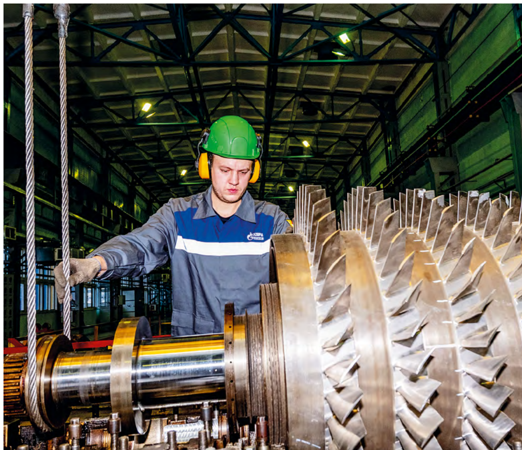
Укладка ротора ОК-ТВД
