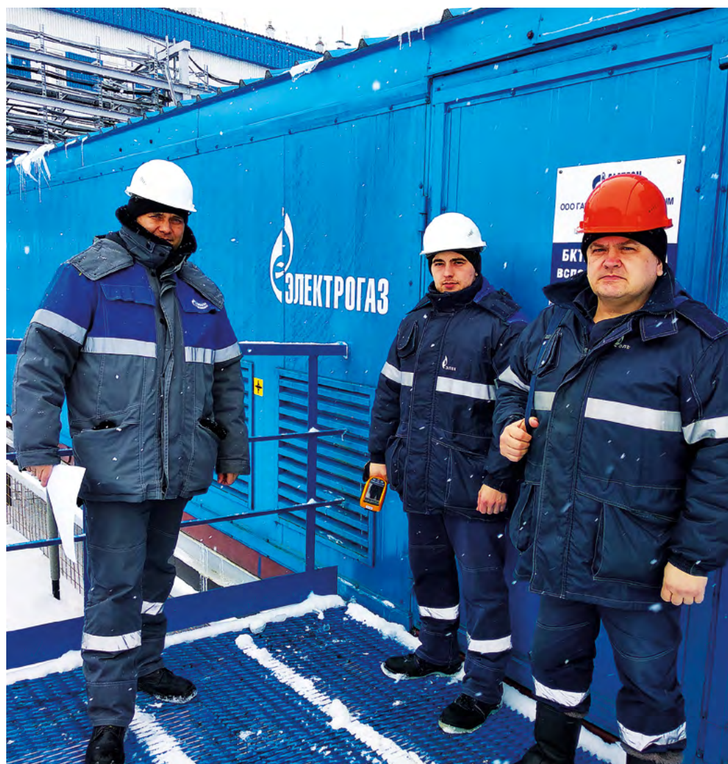
Ремонтная группа готовится к профналадке дизельной электростанции
