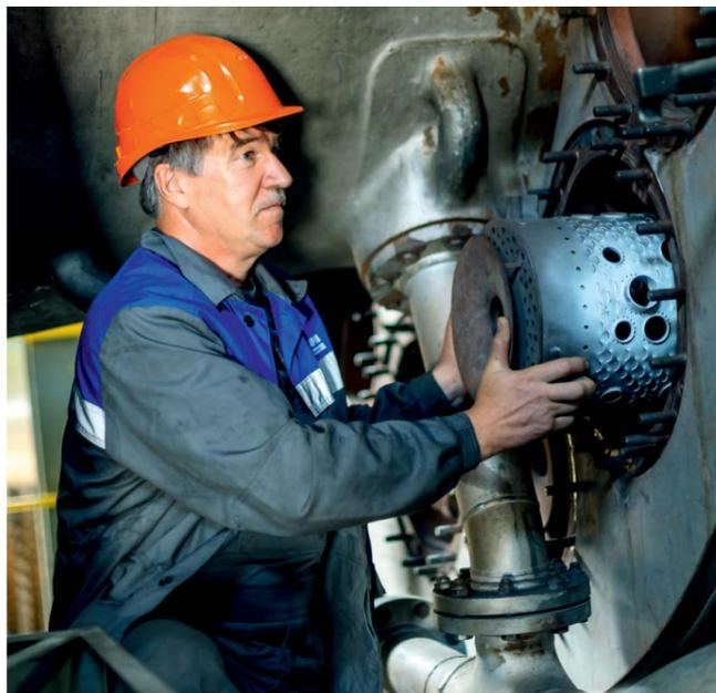
Василий Чекашкин монтирует жаровую трубу, прошедшую дефектоскопию. Поскольку по результатам обследования
