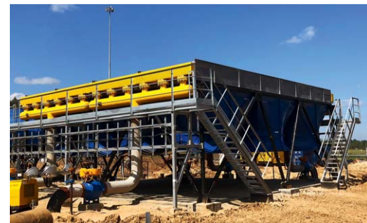
Строительство АВО газа на КС «Юбилейная»
