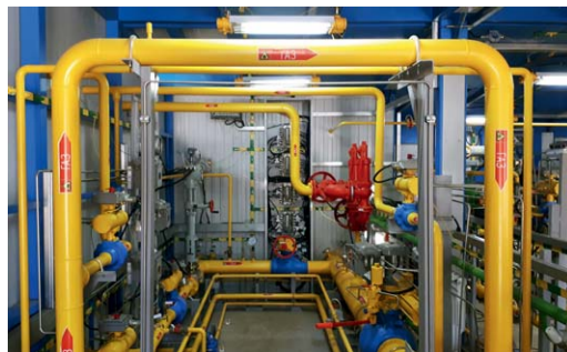
ГРС «Любимов», технологическая обвязка блока
