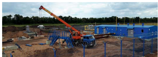
Строительные работы на ГРС-52 «Крестово Городище»
