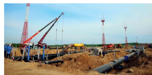
Строительство производственных мощностей газопровода «Сила Сибири»
