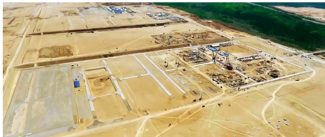
Площадка строительства Амурского ГПЗ
