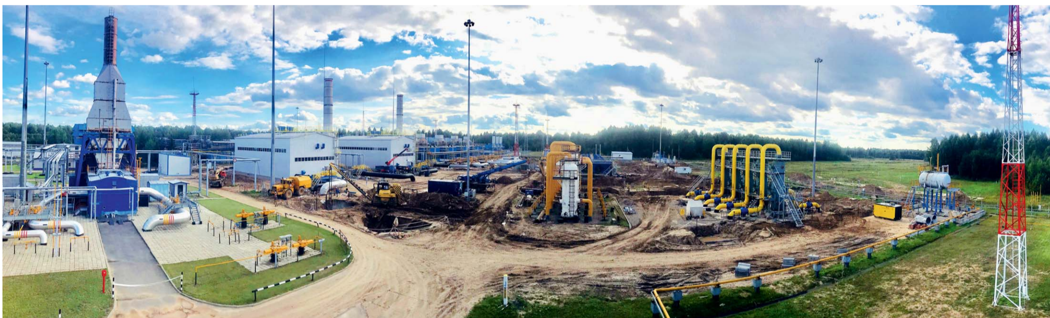
Строительство компрессорной станции «Юбилейная»
