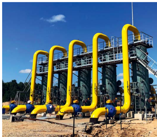
Установка очистки газа на КС «Юбилейная»
