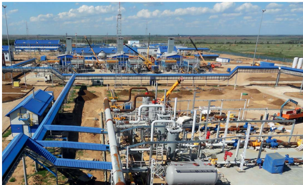
Строительство Волгоградского ПХГ
