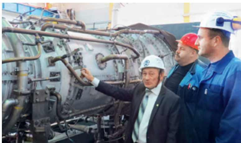
Осмотр двигателя в испытательном боксе
