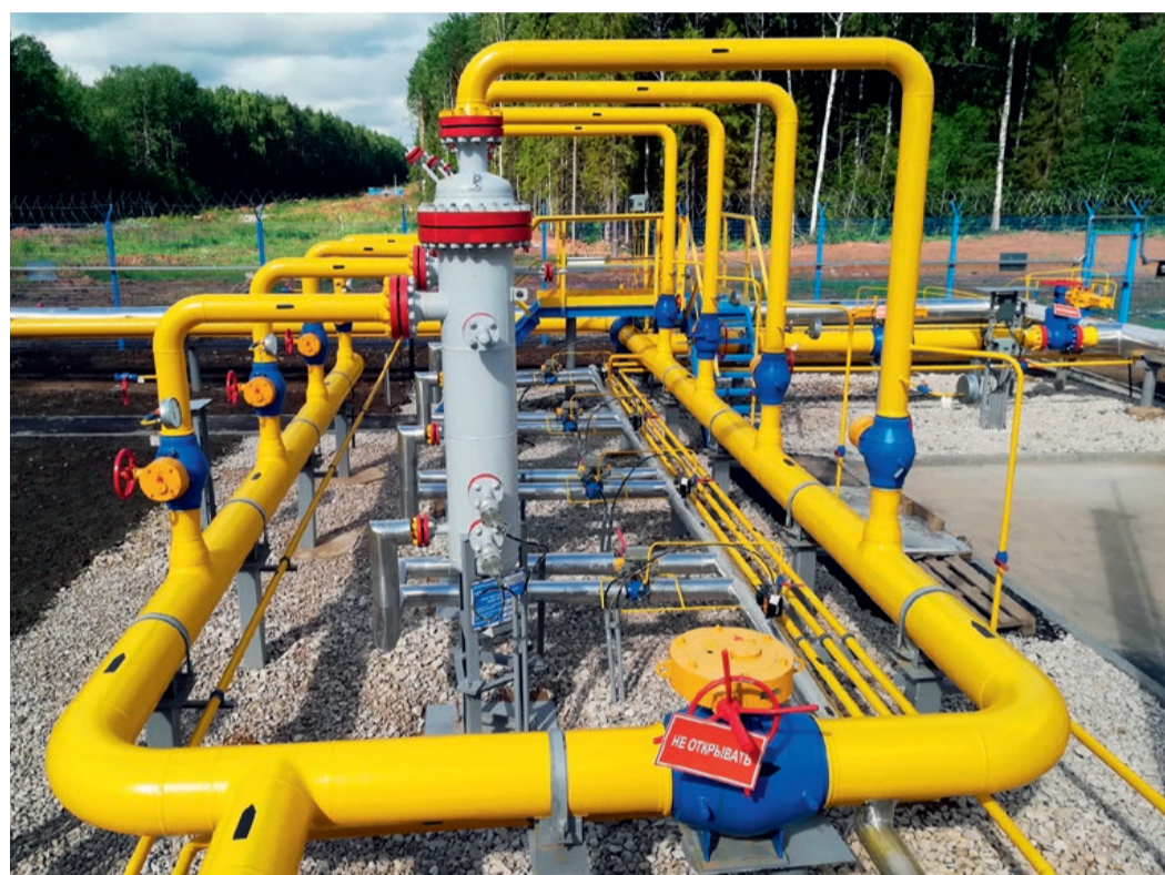
Узел очистки газа, газораспределительная станция в городе Кинешме
