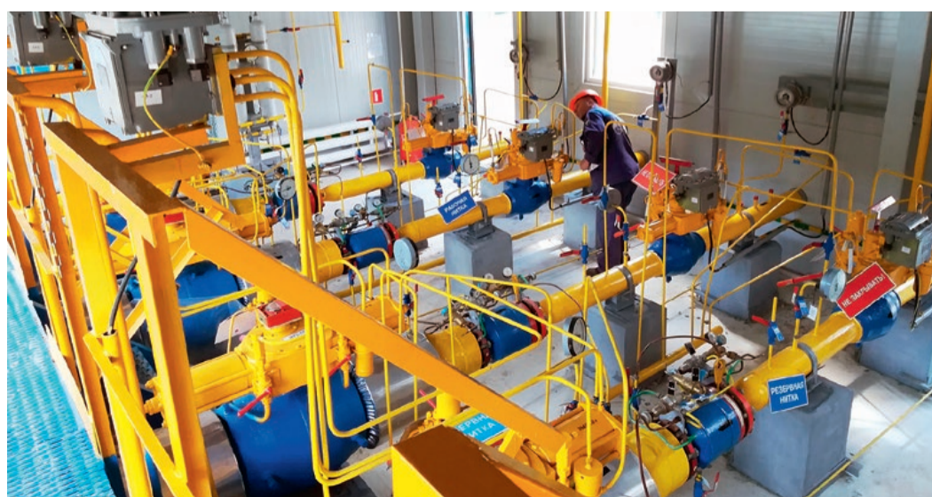
Цех редуцирования газа, ГРС в Кинешме
