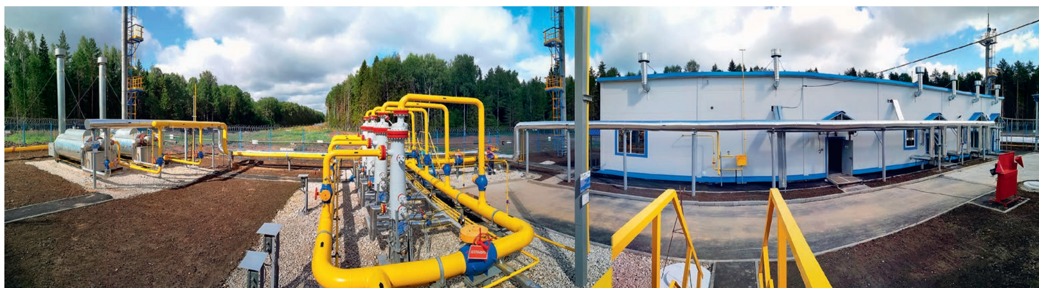
Газораспределительная станция города Кинешмы Ивановской области после реконструкции
