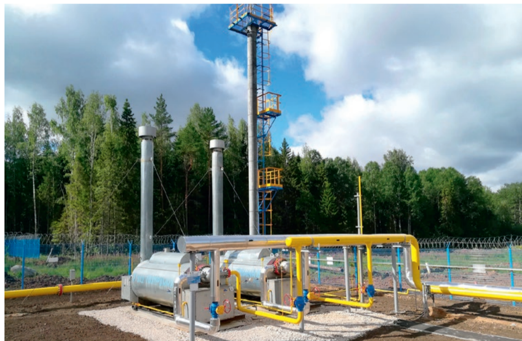
Узел подогрева газа, ГРС в Кинешме
