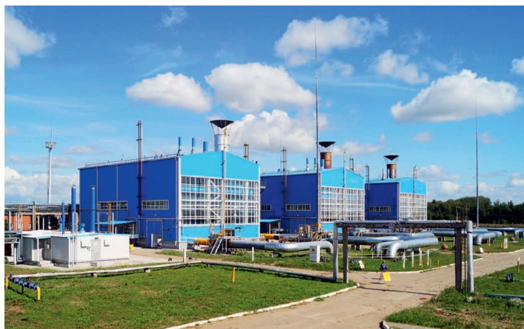
Компрессорная станция «Заволжская» после реконструкции
