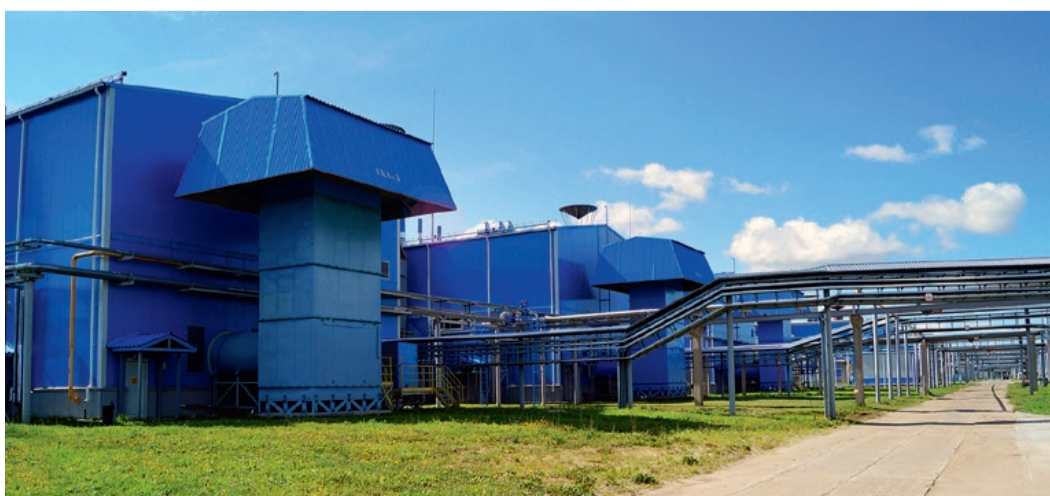
Газоперекачивающие агрегаты на КС «Заволжская»
