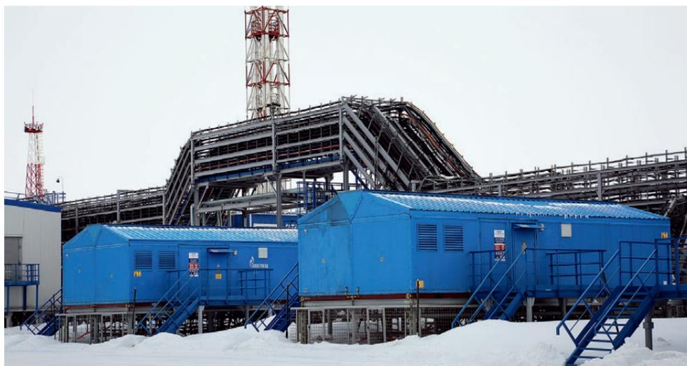
Блочная комплектная трансформаторная подстанция производства АО «Газпром электрогаз» на Бованенковском НГКМ
