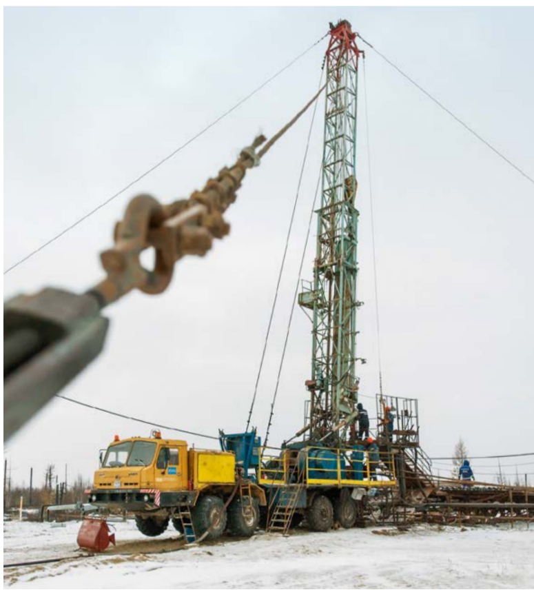
Сварщики управления трудятся не только на базе производственного обслуживания, но и непосредственно на месторождениях в бригадах капремонта скважин
