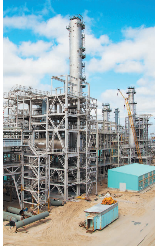
Строящийся Новоуренгойский газохимический комплекс
