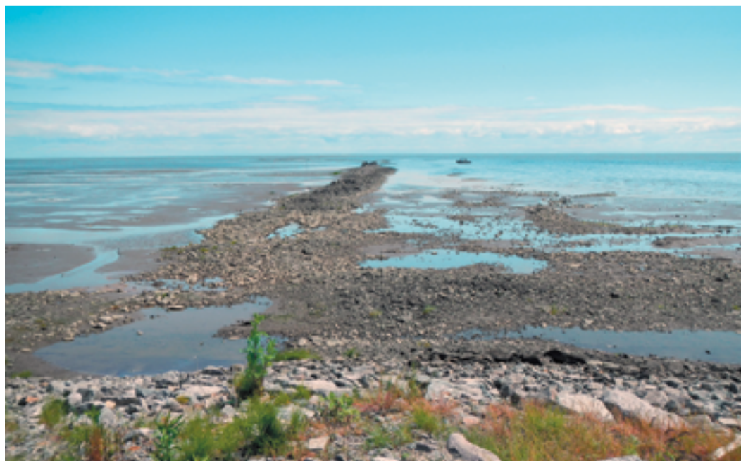
Место работ ООО «ПГЭС» на Сахалине
