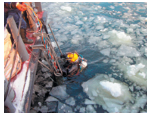
Проведение водолазных работ
