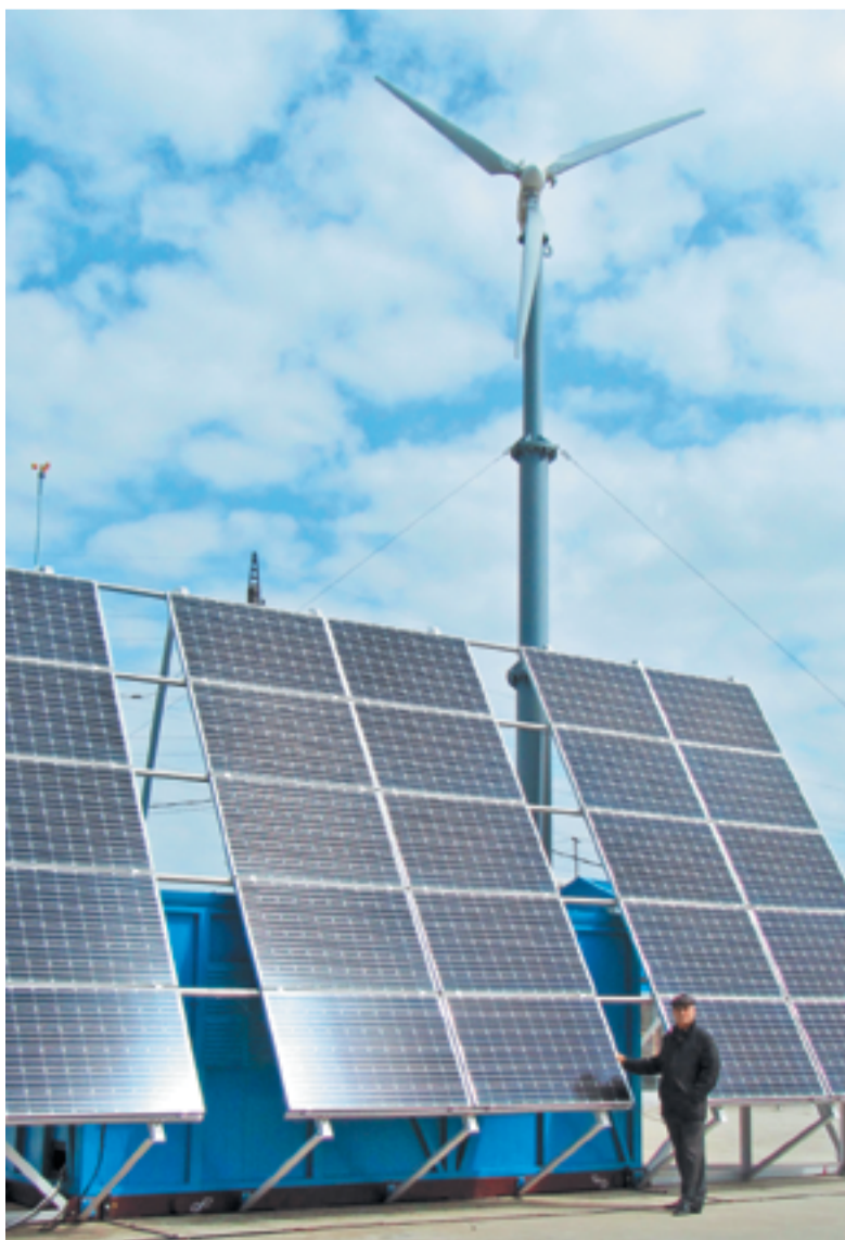
Блочно-комплектное устройство электроснабжения линейных потребителей МГ с применением ветроэнергетической установки и солнечных модулей
