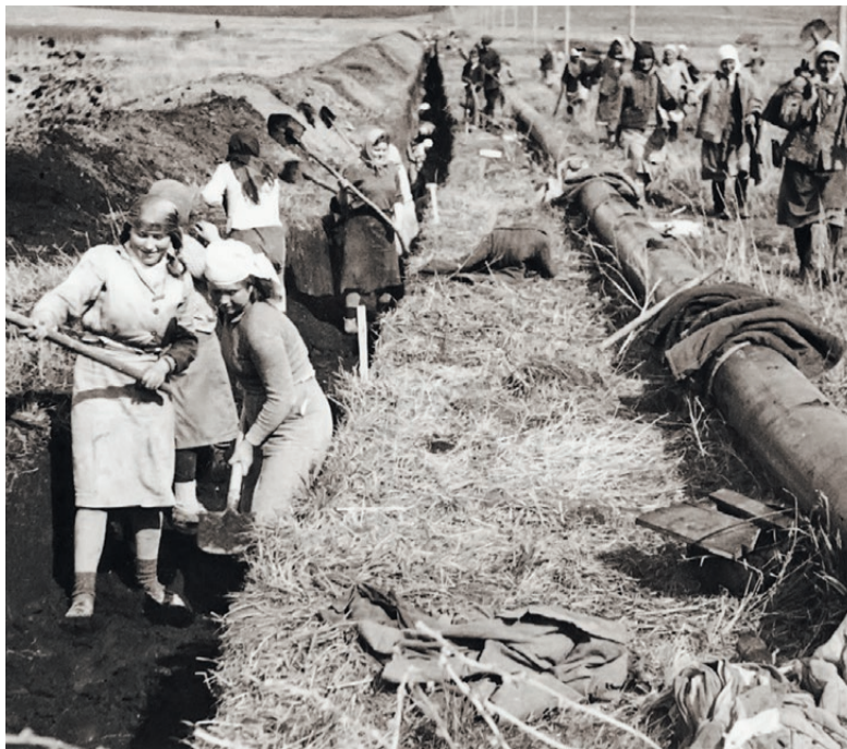
Строительство газопровода Саратов – Москва, 1945 год
