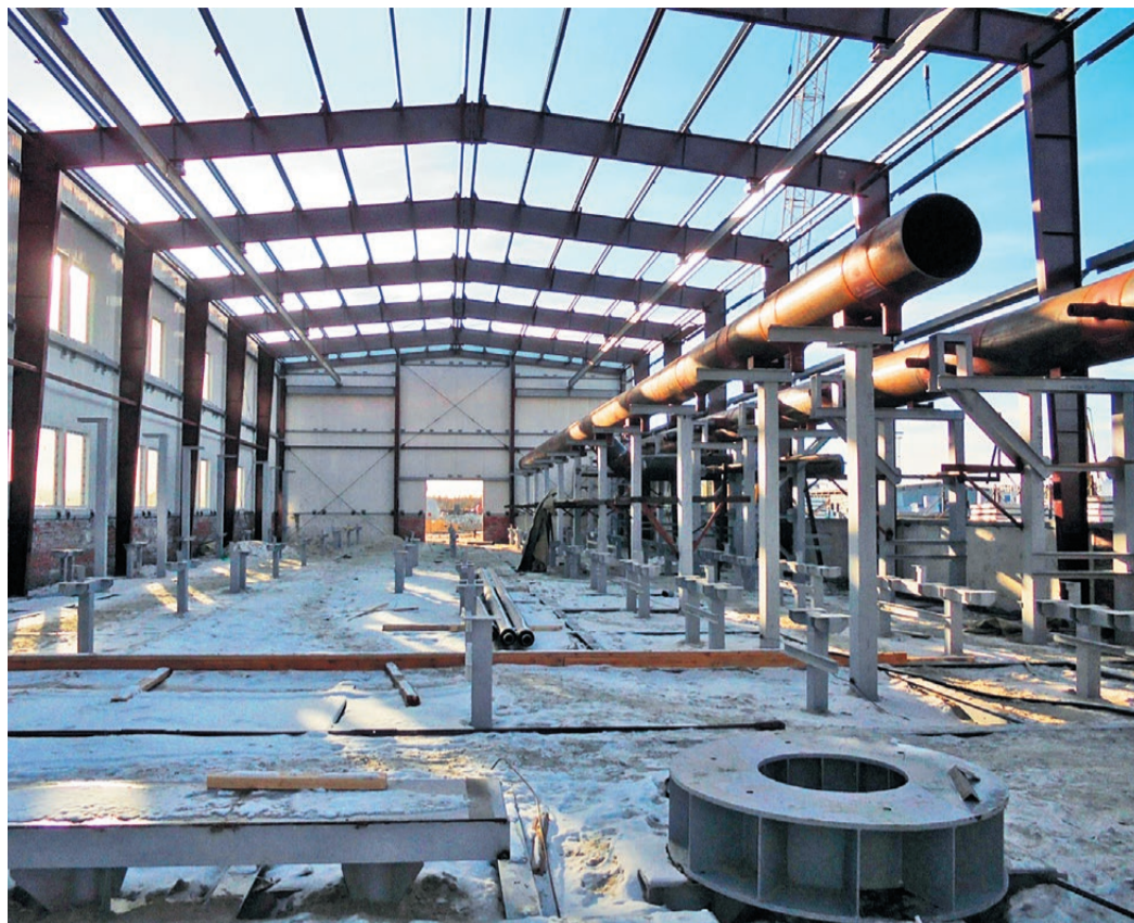
Монтаж производственного корпуса № 3
