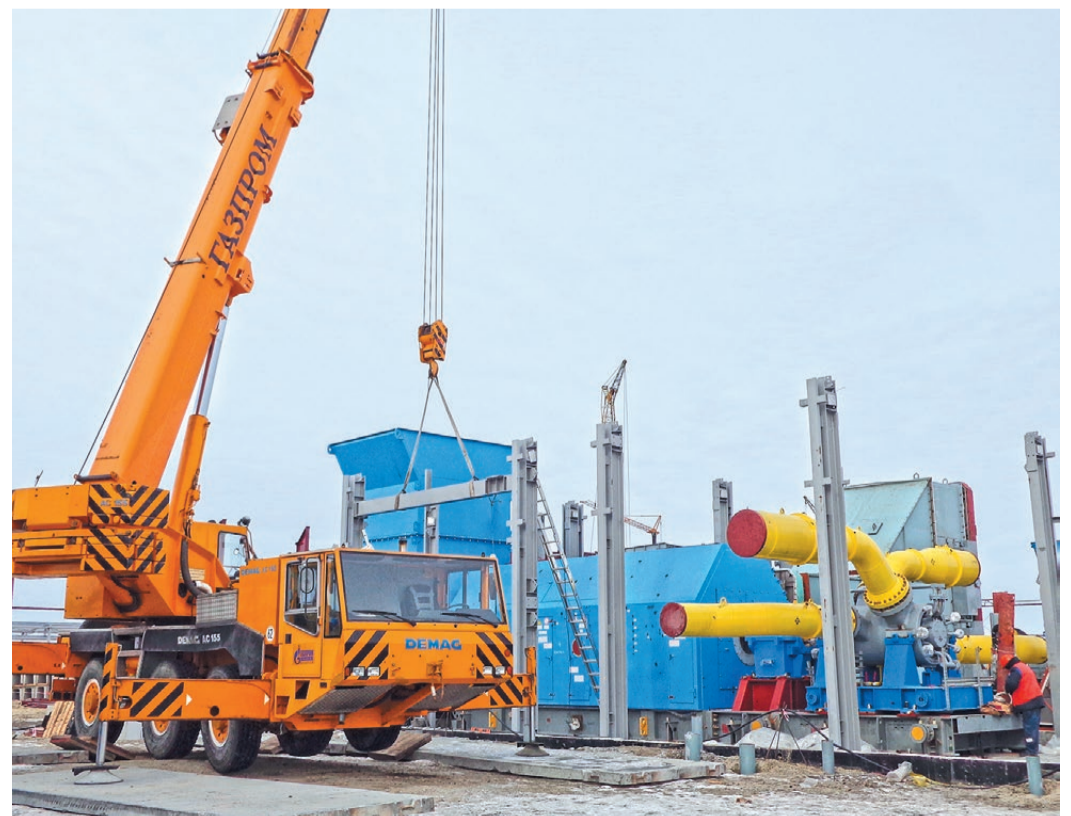
Будущий компрессорный цех
