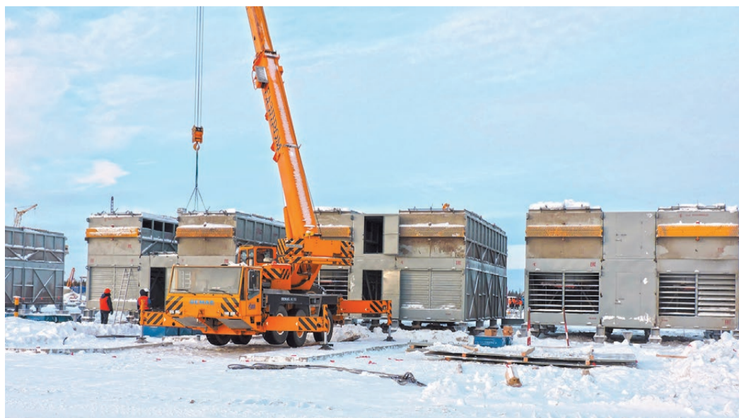
Секции аппарата воздушного охлаждения газа
