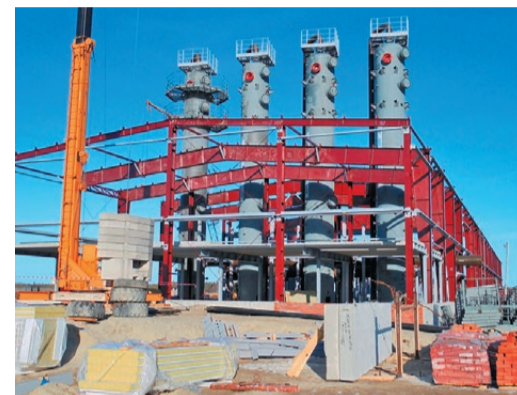
Монтаж производственного корпуса № 1
