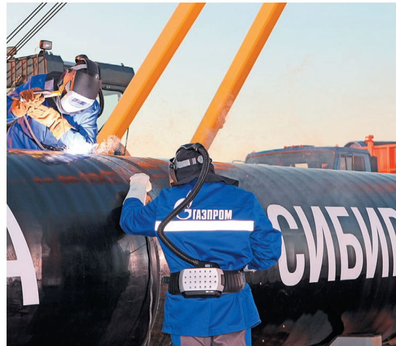
Сварка первого стыка газопровода «Сила Сибири»
