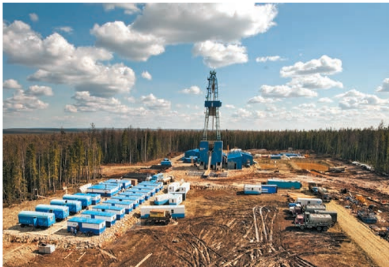
Обустройство Чайнинского месторождения
