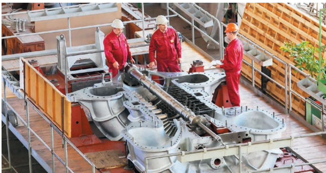
Блочный ремонт ГТТ-12 (ОАО «Газэнергосервис»)
