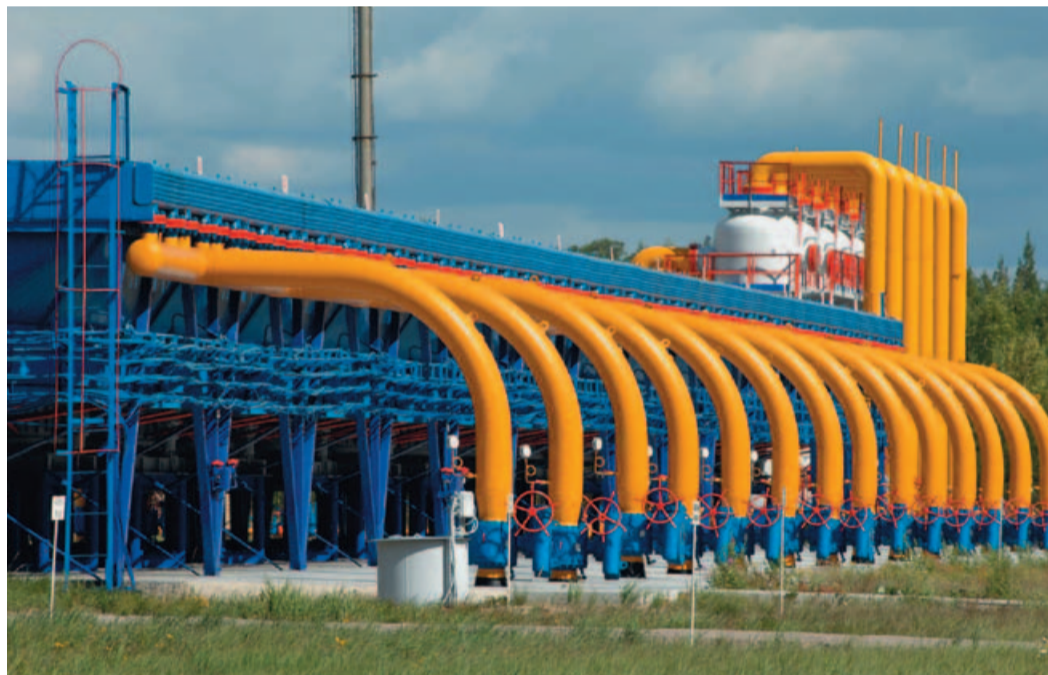
Аппарат охлаждения газа, КС-11 Комсомольское ЛПУ МГ ООО «Газпром трансгаз Югорск»
