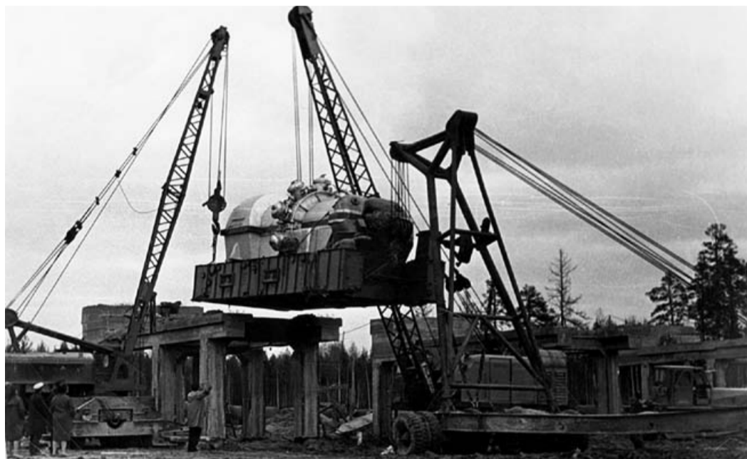
КС «Игрим – Серов». Монтаж турбоагрегата. 1967 год
