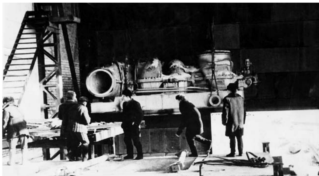
В помещении компрессорной станции «Игрим – Серов». 1967 год
