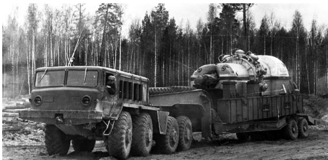
КС 3 «Игрим-Серов» Транспортировка турбоблока к фундаменту. 1967г.
