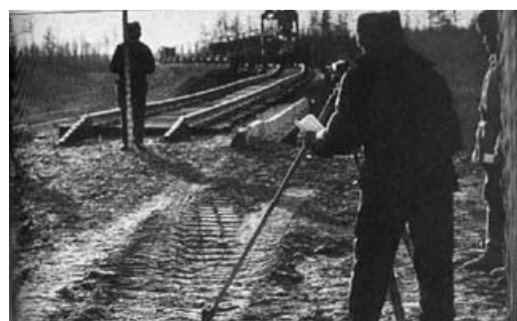
На строительстве трассы Ивдель – Обь
