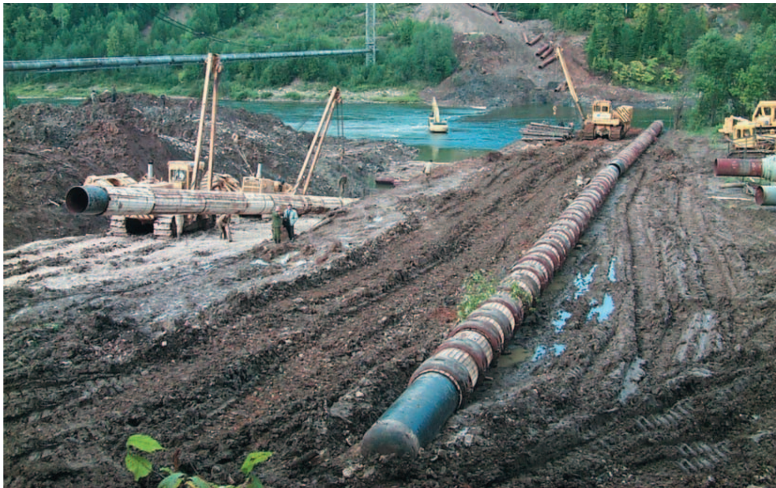
В марте 2012 года входящее в состав ОАО «Газэнергосервис» ООО «Подводгазэнергосервис» отметило 40-летие со дня начала работы. Этой знаменательной дате посвящен специальный выпуск нашей газеты. На фото: подводный переход через реку Чусовая
