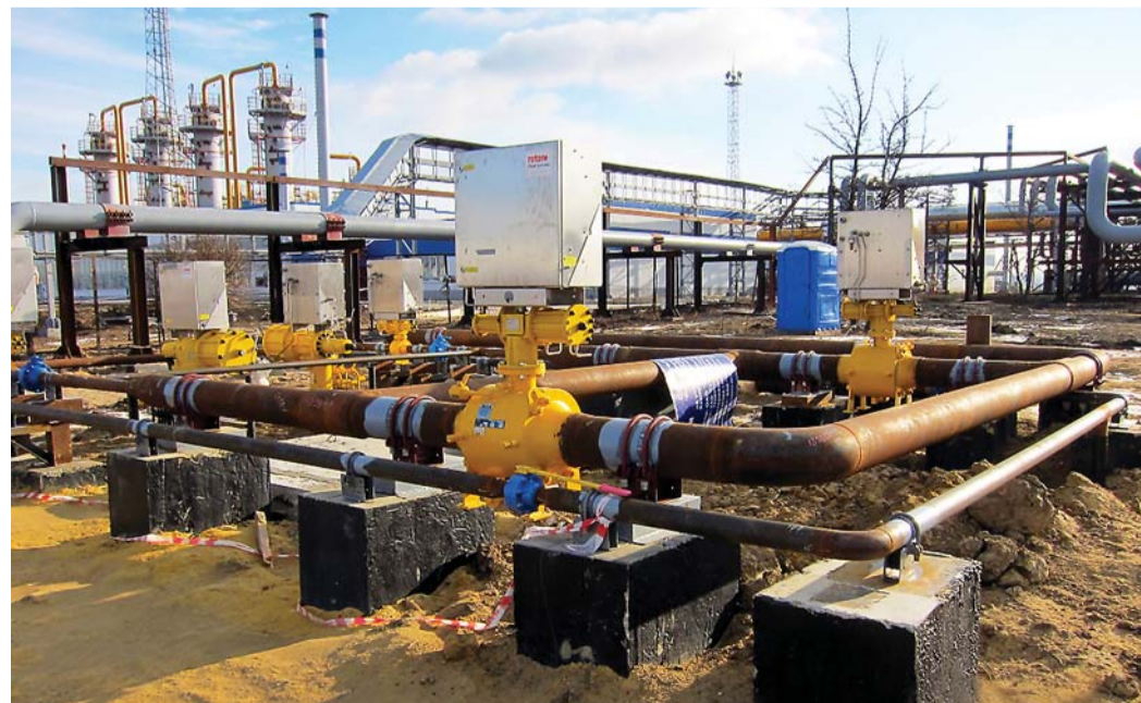
ЗРА на технологическом трубопроводе, Стетовское ПХГ
