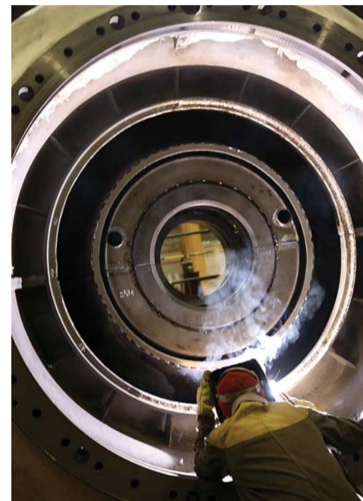
Ремонт корпуса турбины
