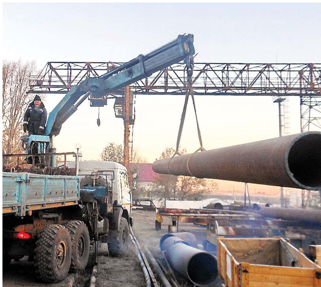
Подготовка труб к транспортировке
