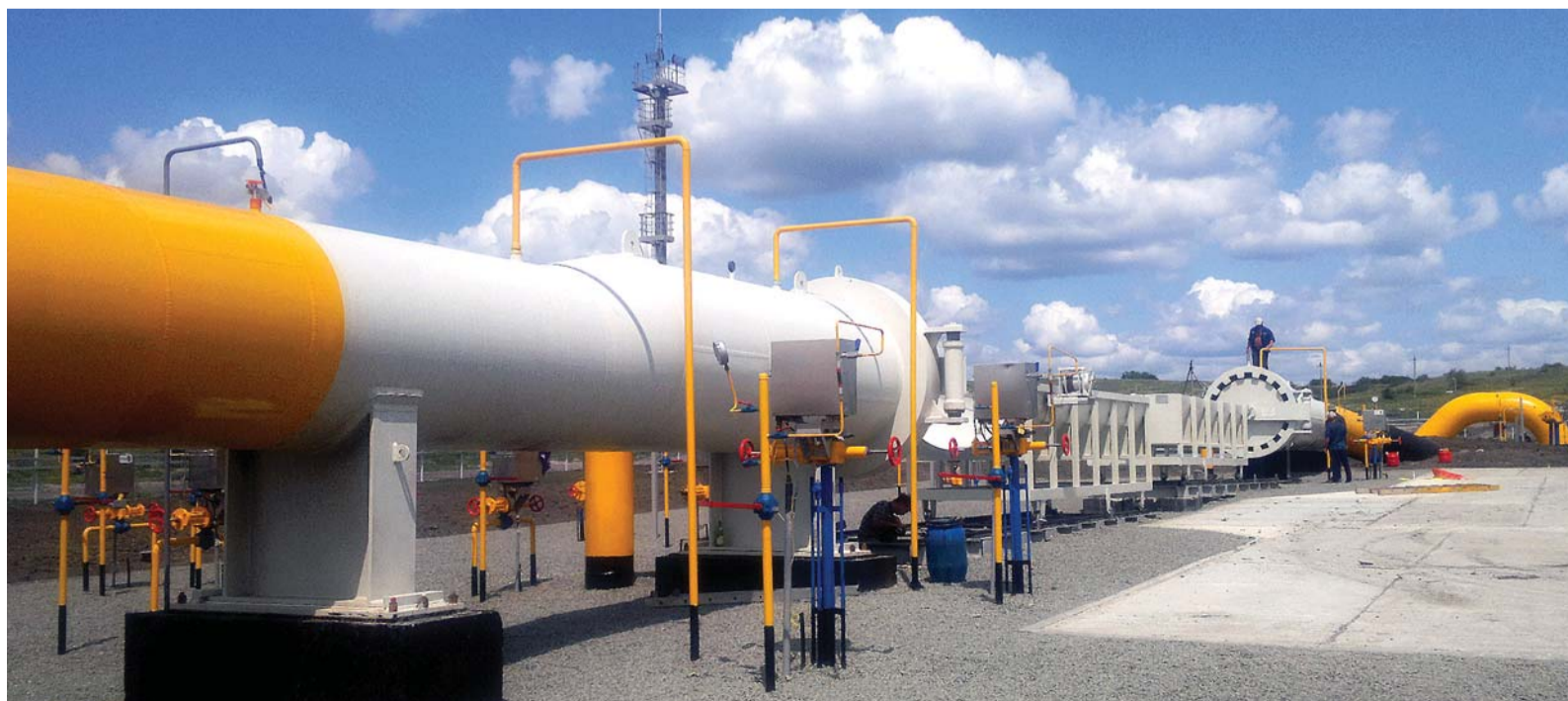
Узел подключения газопровода Писаревка – Анапа, совмещенный с камерами приема и запуска («Южный поток», 1-й этап реконструкции)
