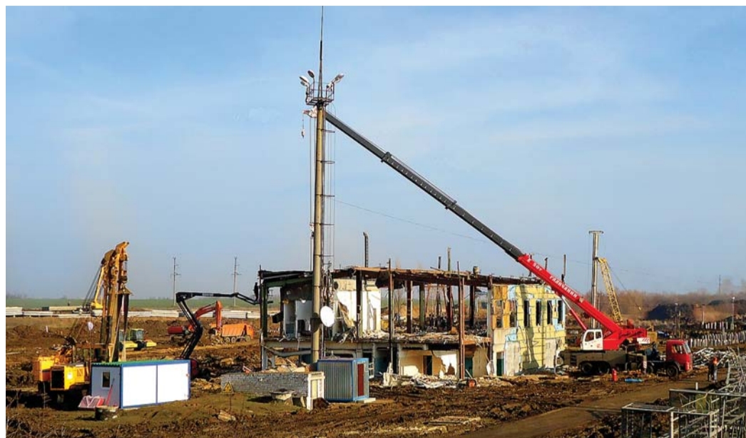
Демонтаж цехов КС «Бубновка»
