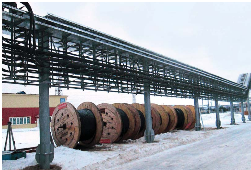
Кабельные эстакады КС «Лонг-Юганская»
