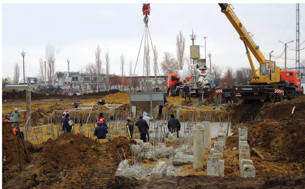
Устройство свайных оснований под фундамент ГПА на КС «Бубновка»
