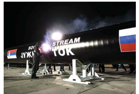
Сварка первого стыка сербского участка газопровода «Южный поток»
