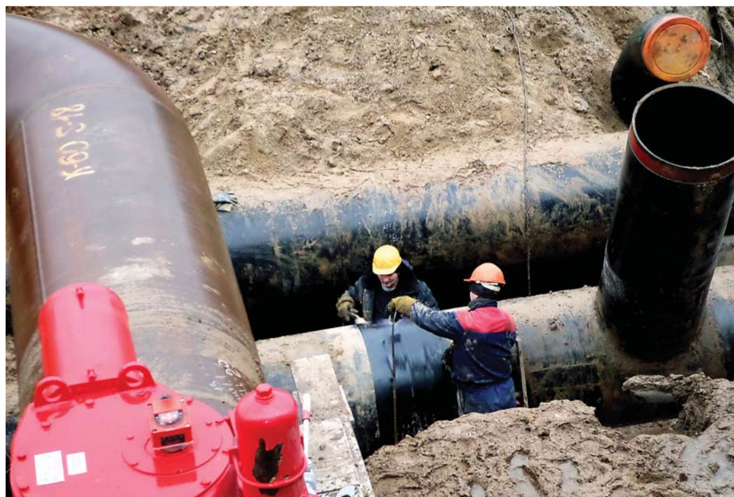
Реконструкция КС «Нюксеница»
