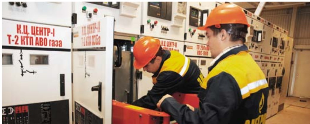
Пусконаладочные работы ЗРУ-10кВ на объекте «Газпром трансгаз Казань»
