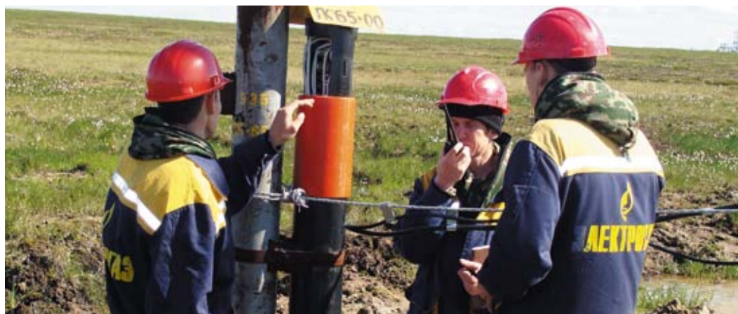
Работы по электротехническим измерениям
