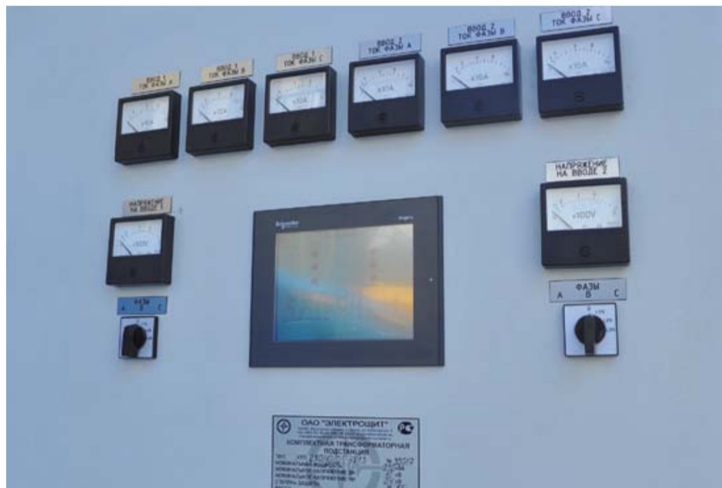
Комплектная трансформатная подстанция ОАО «Электроцит»
