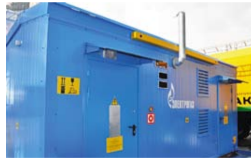
Блочно-комплектное устройство электроснабжения
