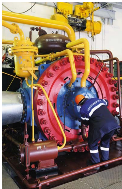
Реконструкция компрессорной станции
