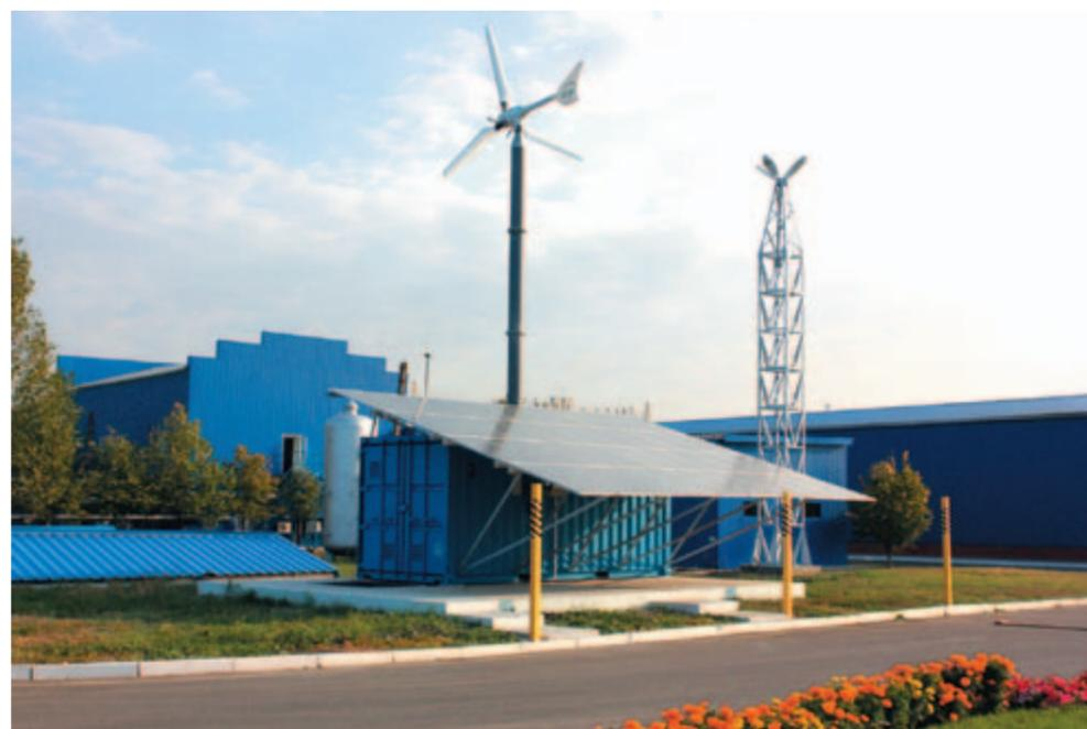
БКЭС-СМ-ВЭУ с использованием солнечных модулей и ветроэнергетической установки крыльчатого типа на территории завода филиала «Афизэлектрогаз», Д х Ш х В 6058 х 2438 х 2591 мм
