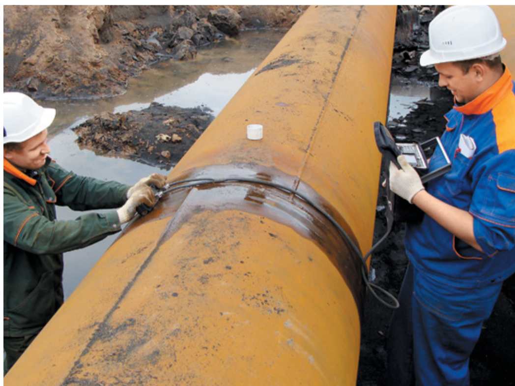
Диагностика при капитальном ремонте технологических трубопроводов. КС «Ржевская»
