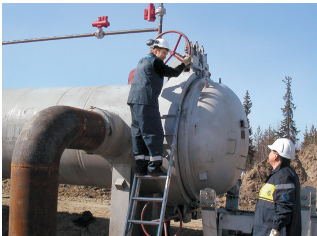
Линейная часть магистрального газопровода (крановый узел). Запуск очистного устройства
