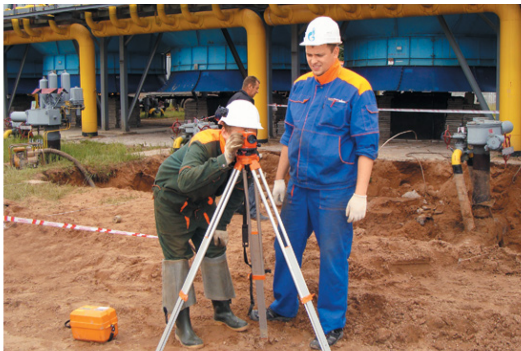
Работы по диагностическому обследованию аппарата воздушного охлаждения газа. КС «Ржевская»
