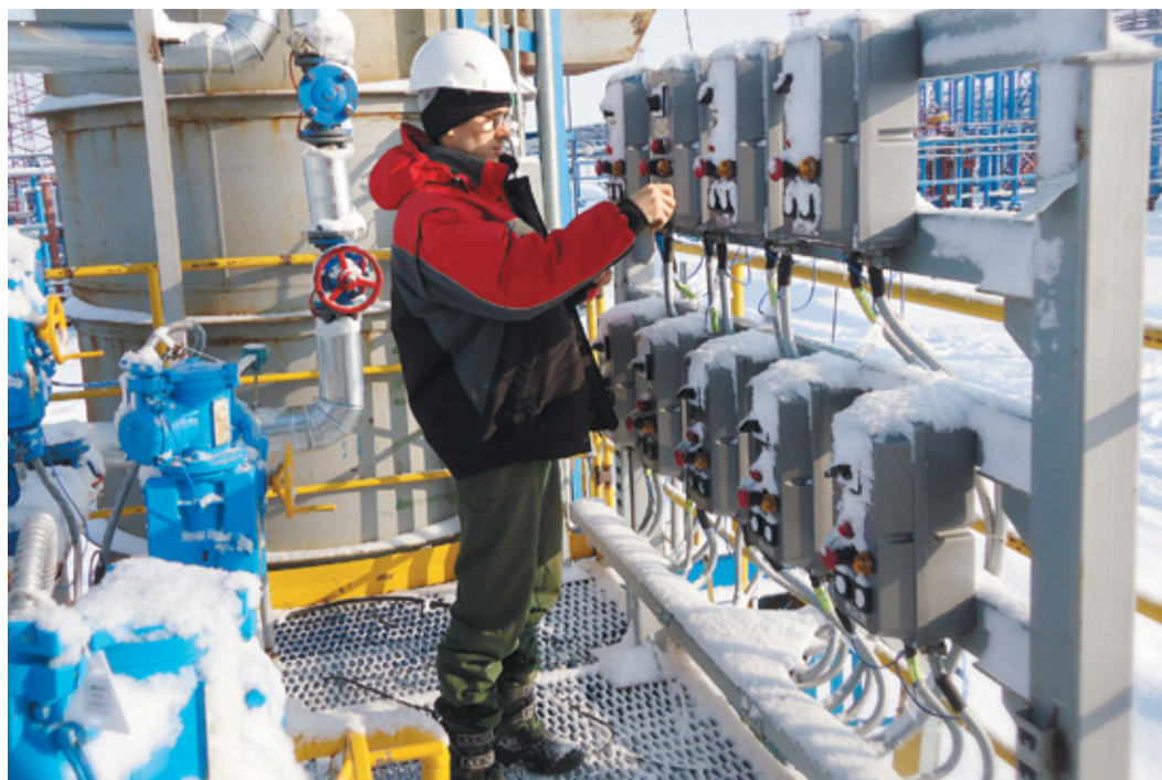
Пусконаладочные работы на КС «Газарацкая»
