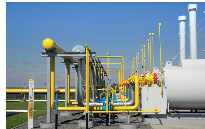
Расширение Касимовского ПХГ. Установка системы очистки газа
