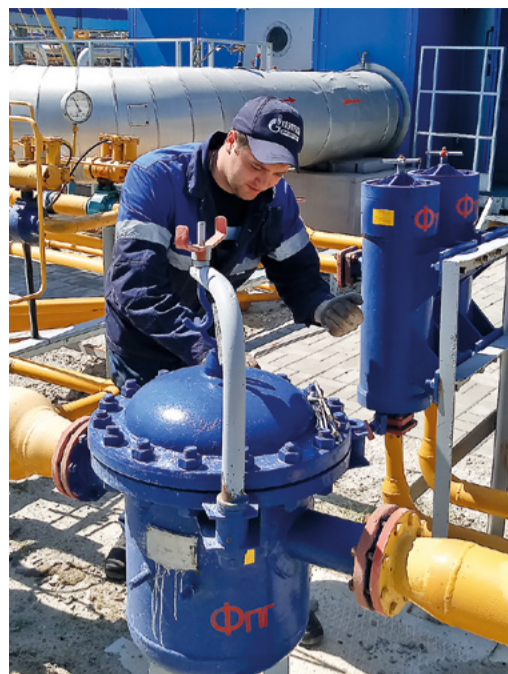
Замена фильтра пускового газа
