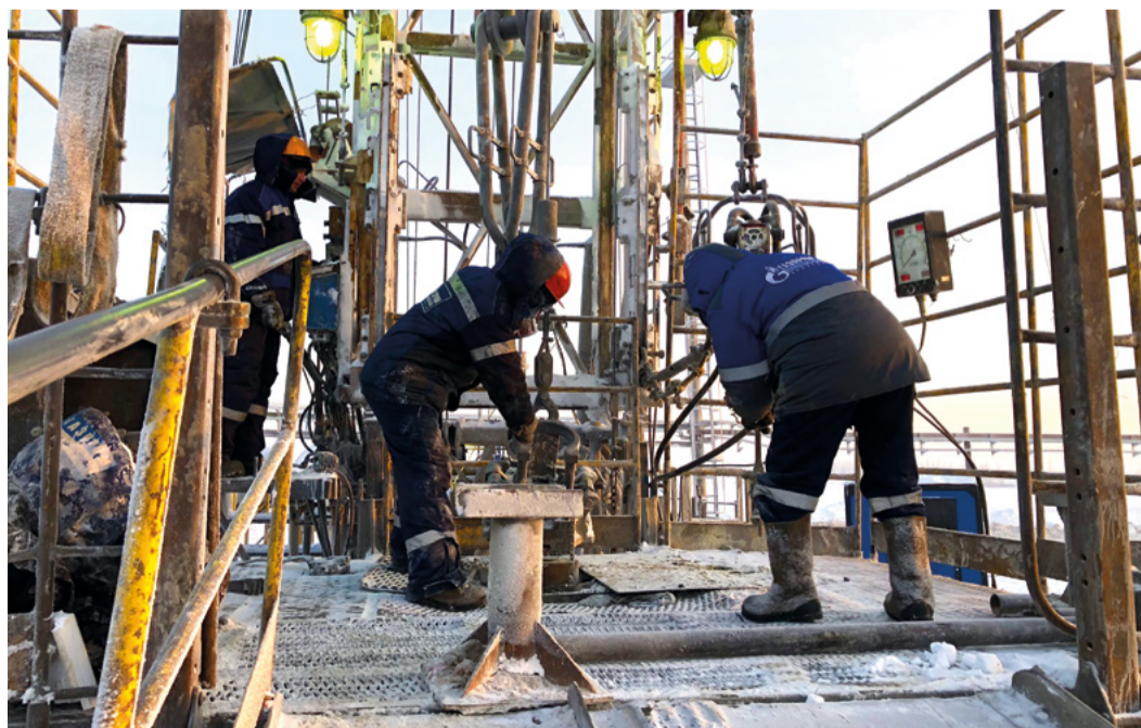
Мастера ремонта скважин ООО «Газпром подземремонт Уренгой»
