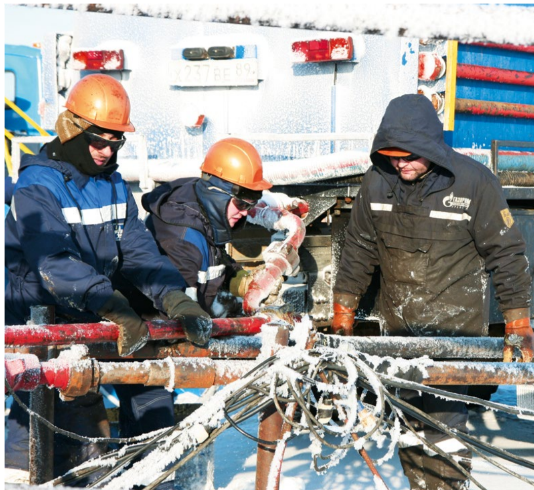
Работа на северных объектах – это морозы почти круглый год
