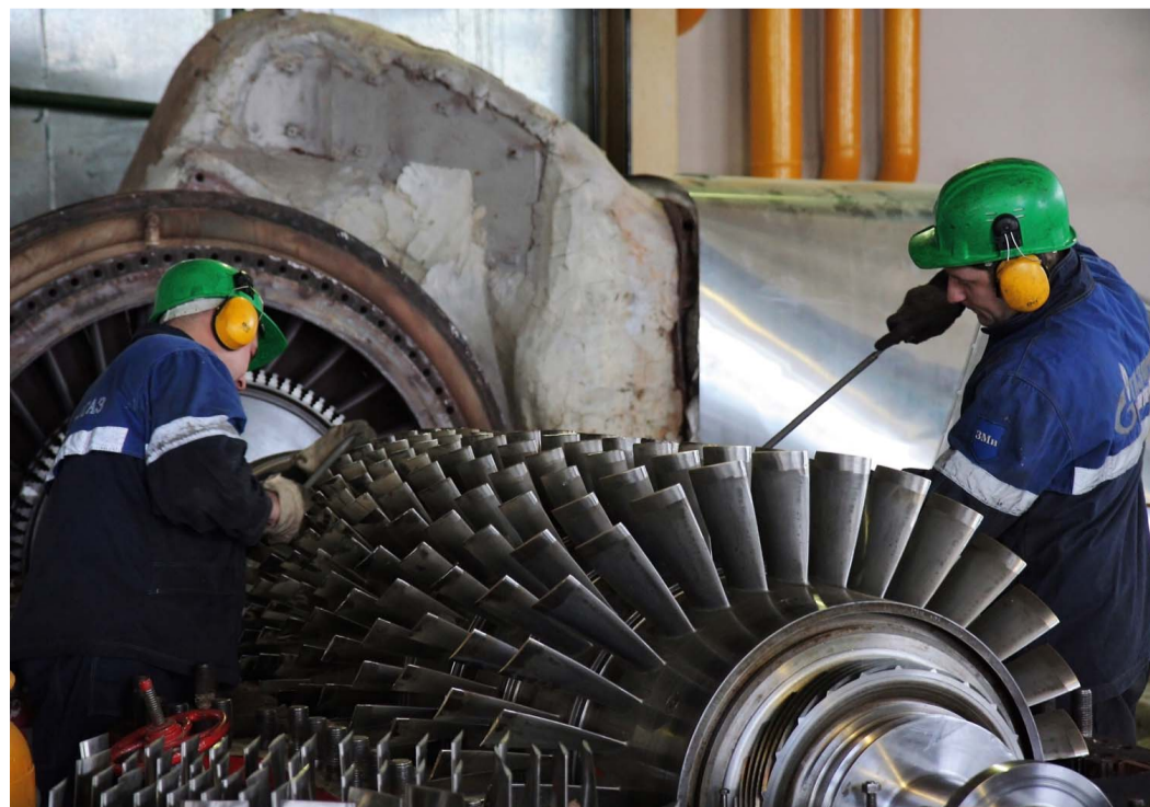
Опилка рабочих лопаток осевого компрессора ГТК-10
