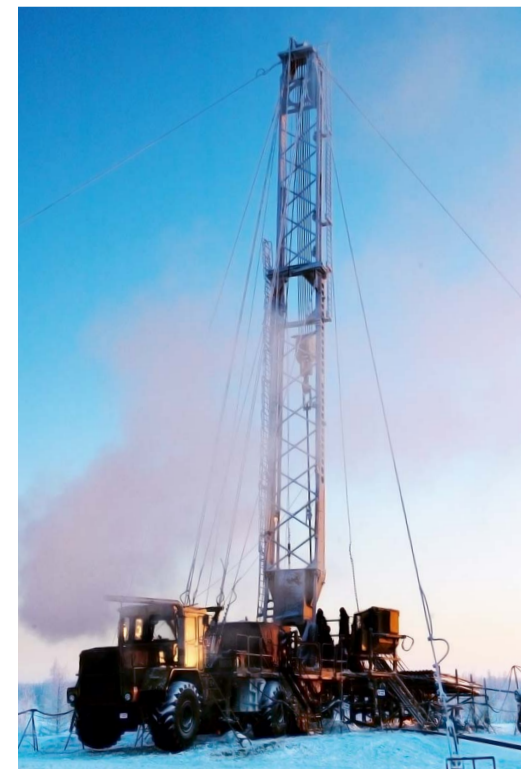
Капитальный ремонт скважин
