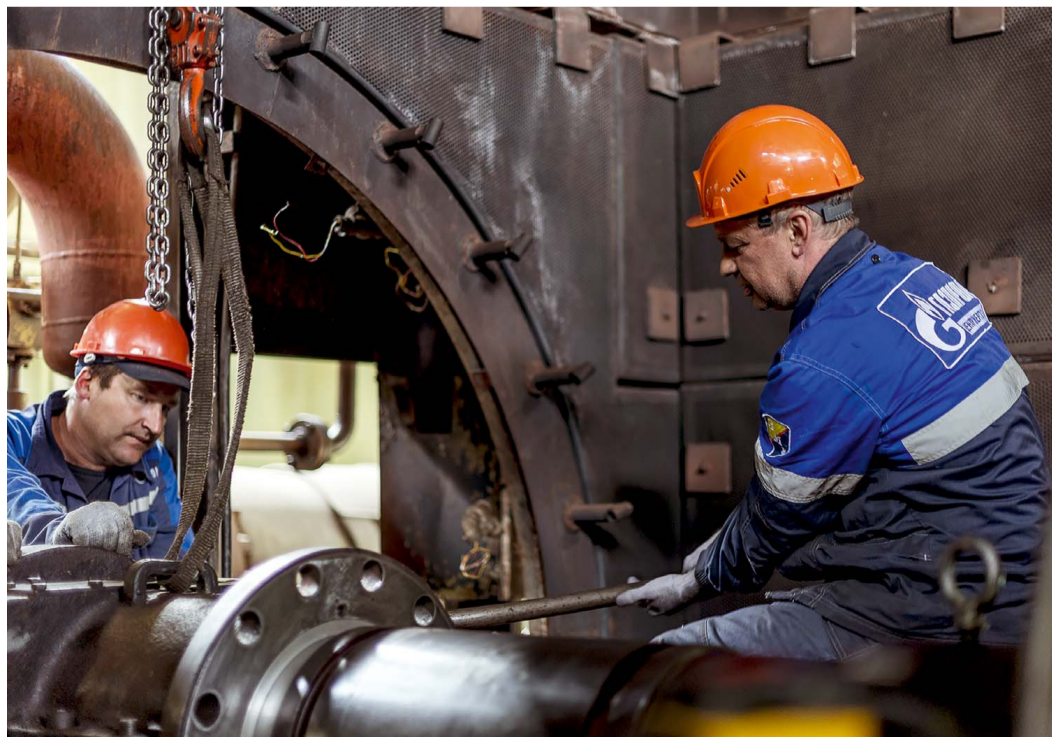
Монтаж ротора турбины низкого давления
