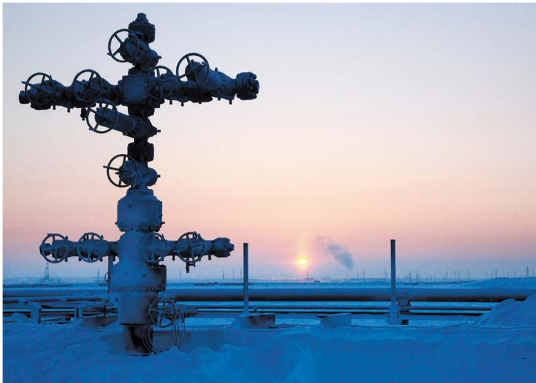
Газовая скважина на Бованенковском НГКМ. Фото с сайта ПАО «Газпром»
