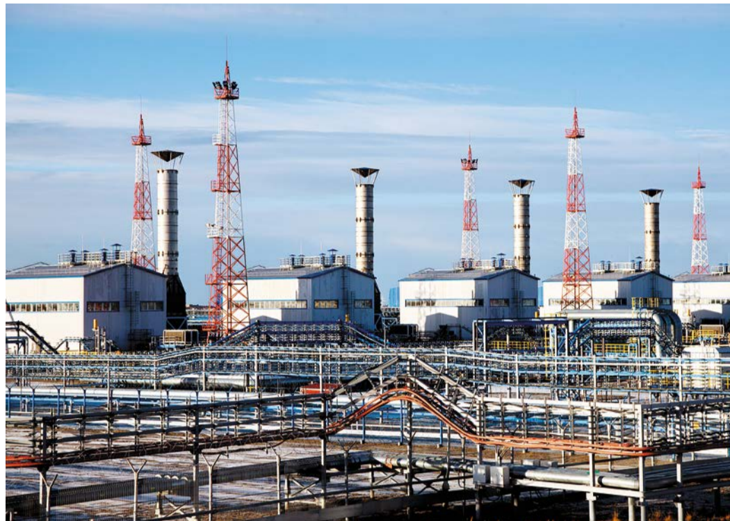
Дожимные компрессорные станции. Фото с сайта ПАО «Газпром»
