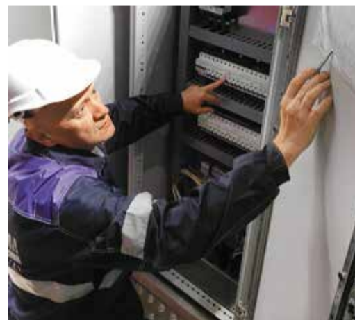
О.Л. Плотников производит сервисное обслуживание низковольтных комплектных устройств ГПА ДКС-2 очереди ГП-2 Бованенковского НГКМ
