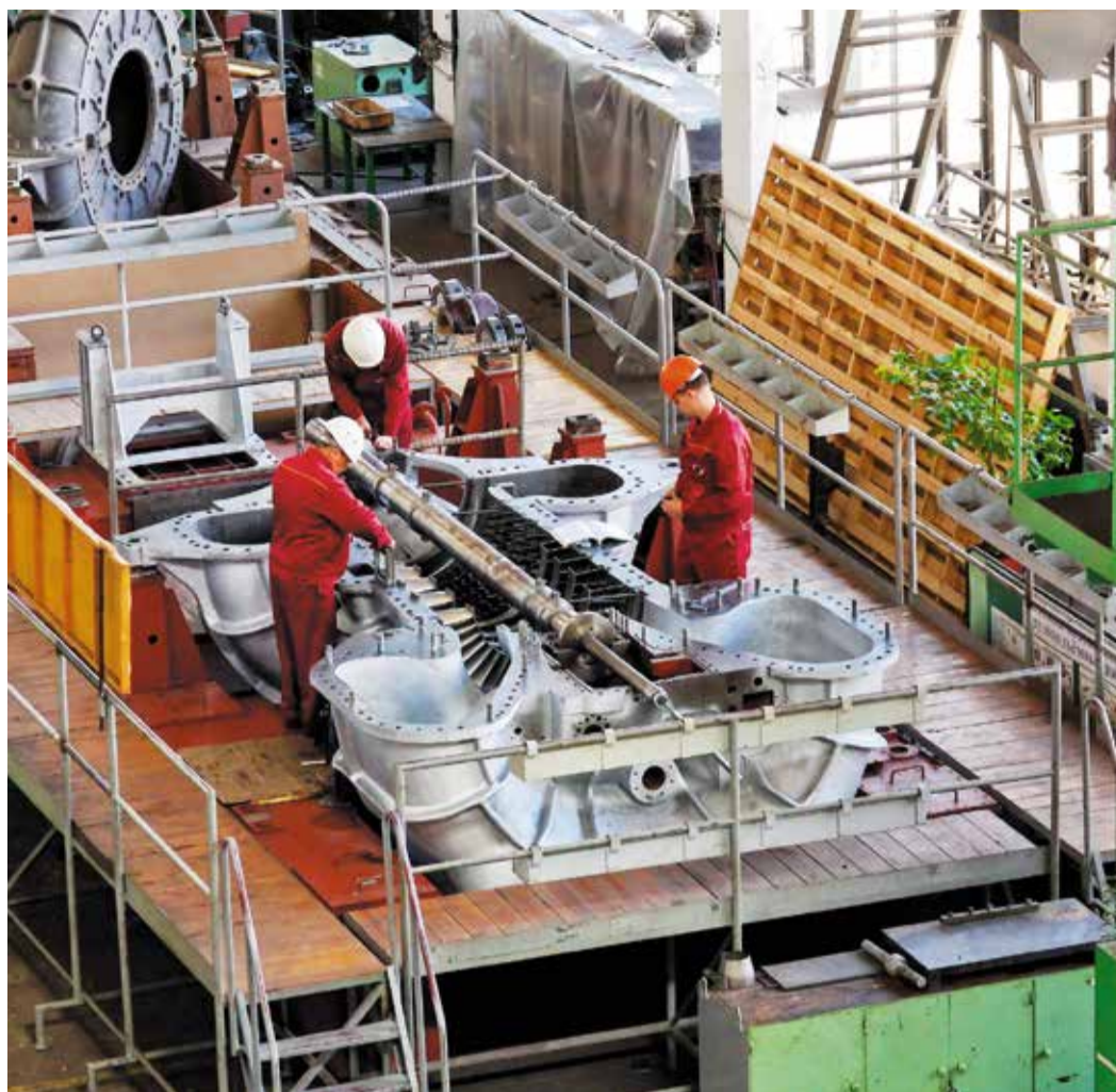
Блочный ремонт газовых турбин
