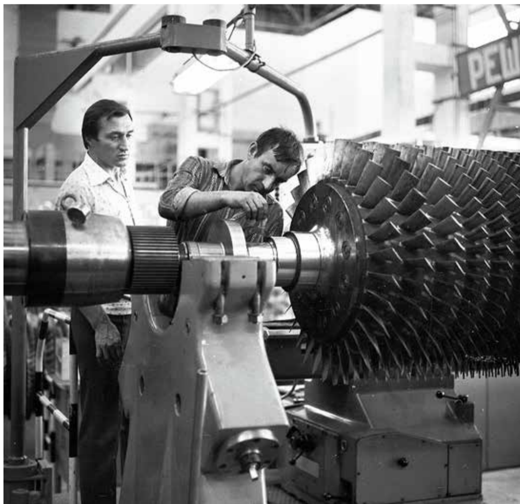
Процесс обработки шеек ротора. Конец 1980-х годов
