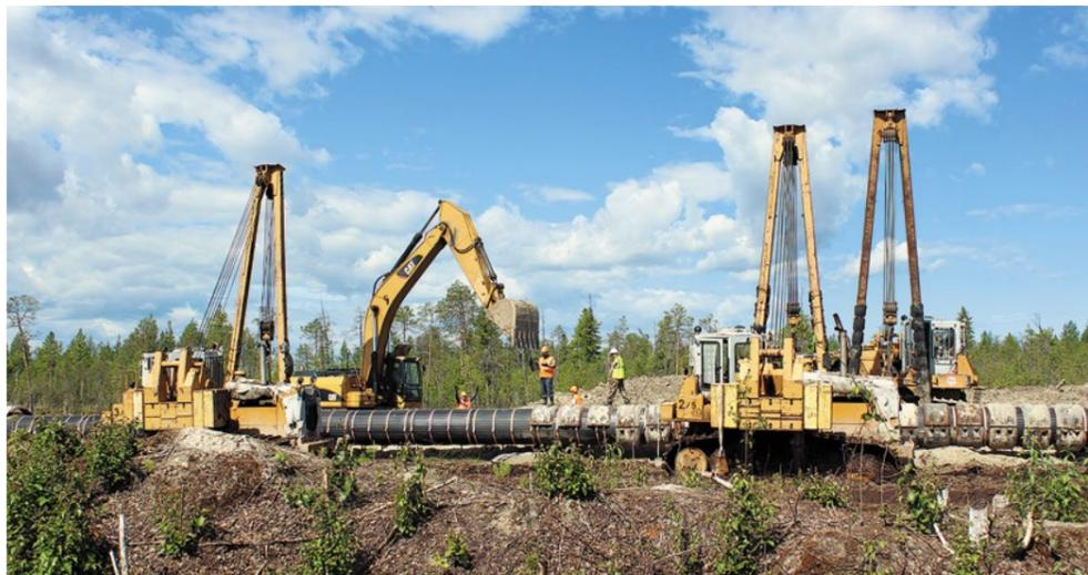
Шлейфы газопровода Вуктыл – Ухта: укладка 1-й нитки газопровода в траншею
