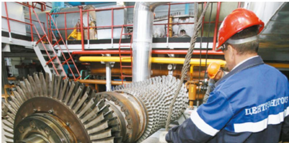
Демонтаж ротора компрессорной группы газоперекачивающего агрегата ГТН-25-1
