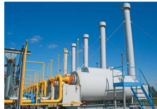
При реконструкции ГРС «Косиново» использовались передовые технологии и оборудование
