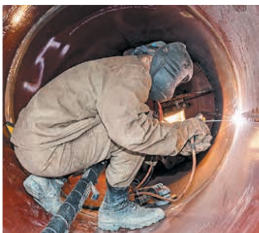
При эксплуатации газопровода и добычных объектов «Газпрома» в Якутии необходимо будет задействовать около 3 000 специалистов
