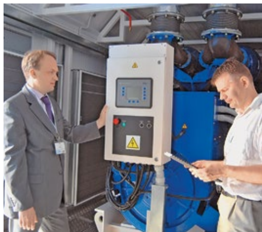
Главный конструктор ОАО «Электроцит» Е.А. Руднев и заместитель генерального директора по производству ДОО «Электрогаз» М.А. Домничев
