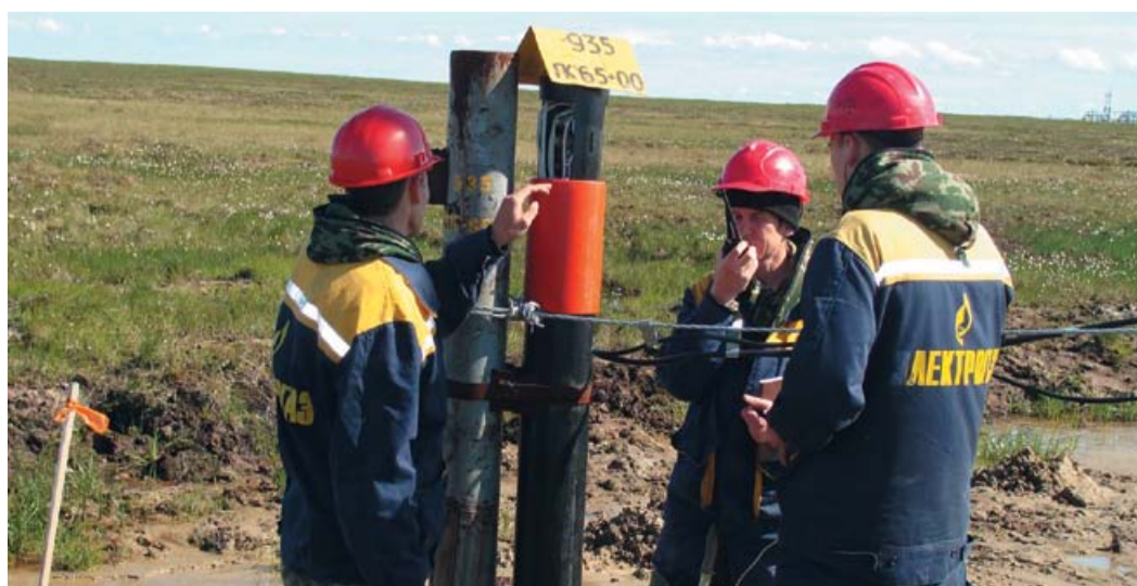
Электрометрическое (коррозионное) обследование линейной части
