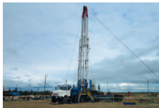
Подъемная установка КРС
