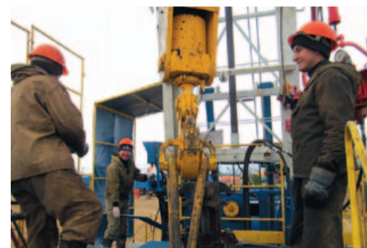
Ремонт скважины: спуско-подъемные операции
