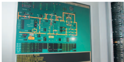
Панель оператора САУ АГРС
