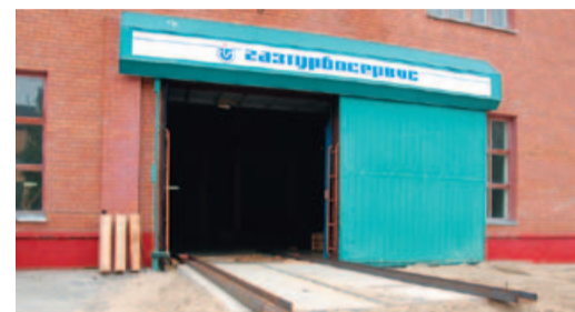
Рельсы для транспортировки ГПА в цех
