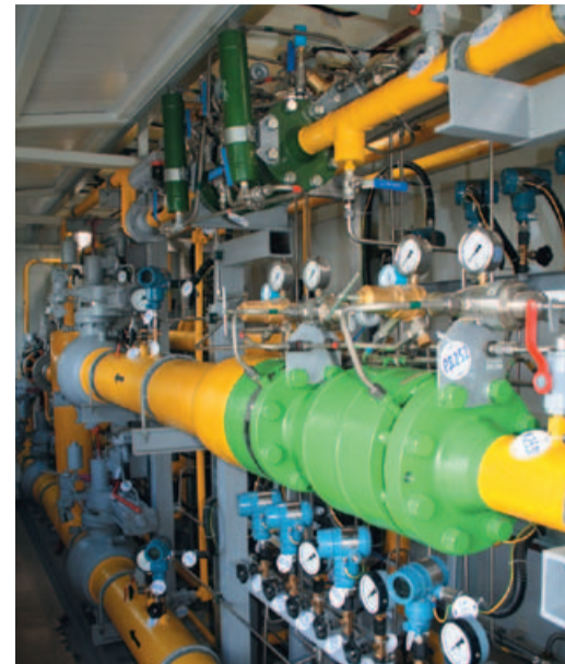
Блок-бкс технологический. Линии редуцирования
