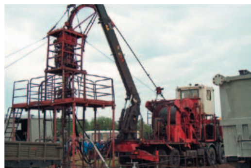
Колтюбинговая установка на Оренбургском ГКМ
