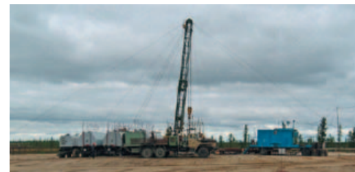
Капитальный ремонт скважины в тундре
