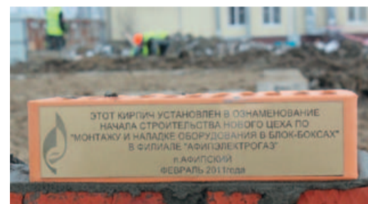
Памятный кирпич, заложенный при строительстве
