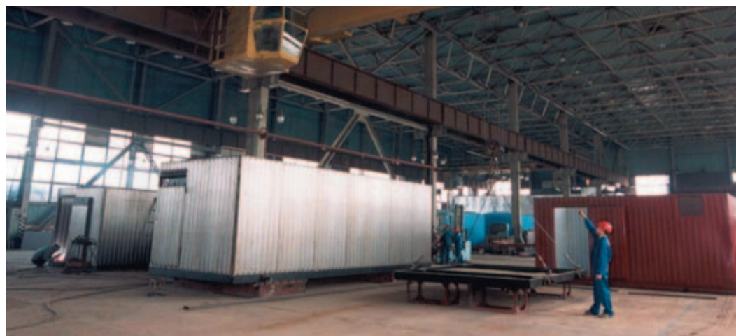
В цехе по изготовлению блочно-комплектных подстанций в 90-е годы
